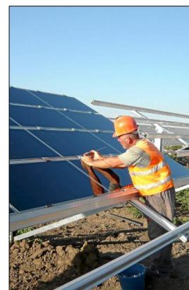
Un empleado de la empresa Anasol trabajando en la instalación de paneles en el huerto solar de Cortijo del Cura en Antequera. / EL MUNDO
