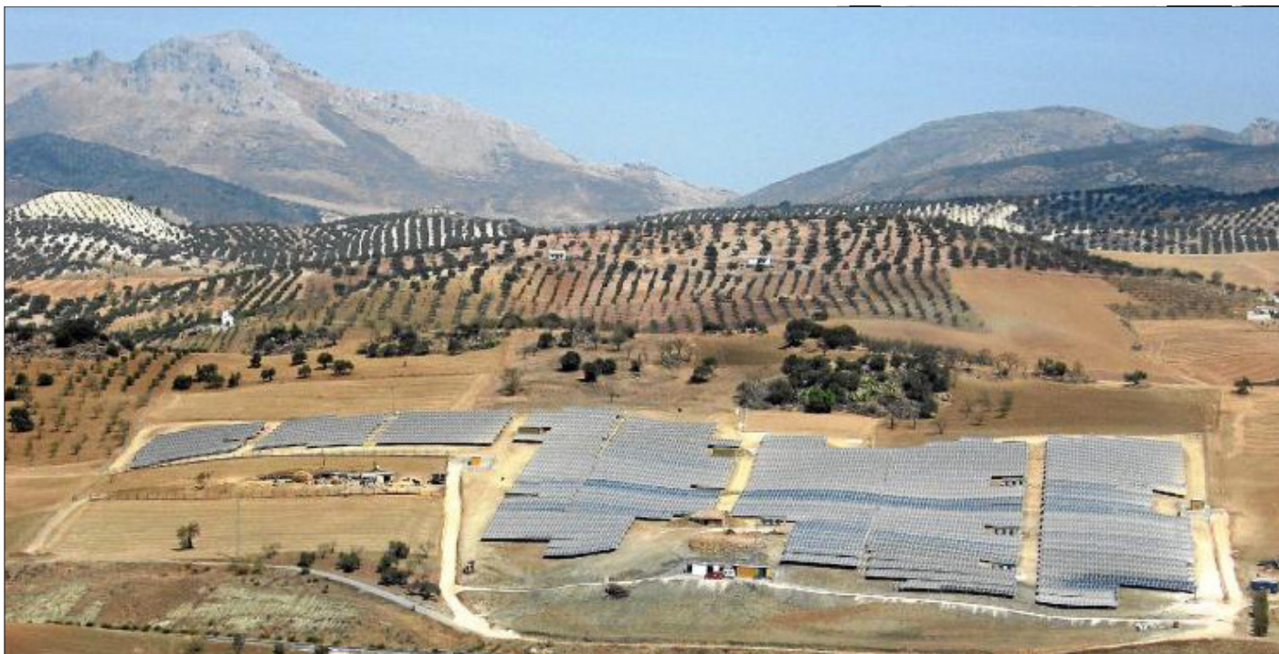
Vista general del parque solar fotovoltaico que la empresa Anasol ha instalado en Casabermeja. / EL MUNDO
